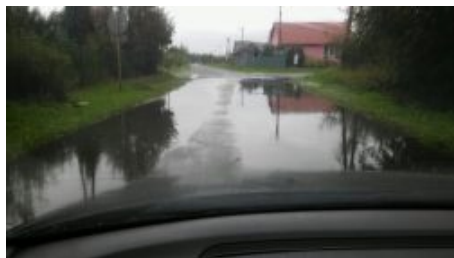
Zahajki przed przebudową
