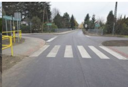
Zahajki po przebudowie
