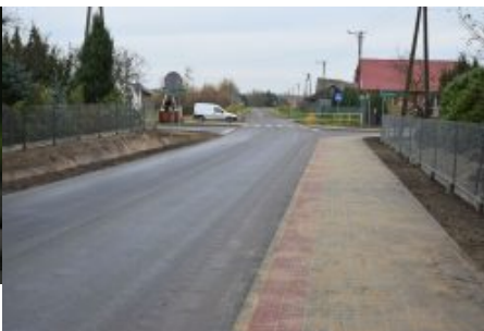
Zahajki po przebudowie
