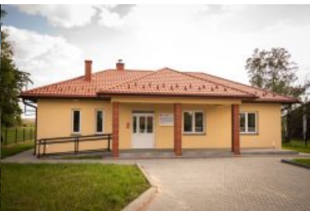
Nowa świetlica w Wyrkach-Wola
