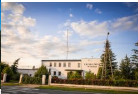
Gmina Wyryki - budynek po remoncie
