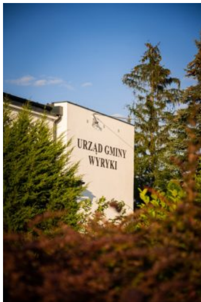
Budynek Urzędu Gminy Wyryki
