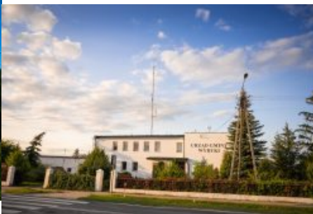
Gmina Wyryki - budynek po remoncie
